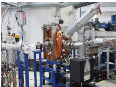
รูปที่ 7 ตำแหน่งการติดตั้ง RF Cavity บริเวณด้านหน้าชุดแม่เหล็ก U60 undulator
